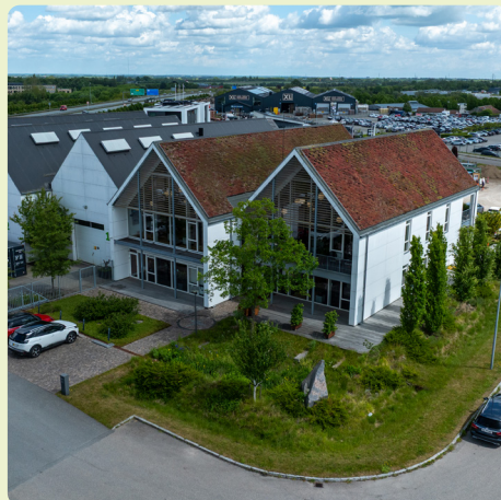
↑ Genanvendelse af vand, Malmoshuset, Danmark
